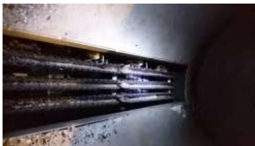
Gambar 4 Pergantian Burner Head Pada Mesin Roasting
