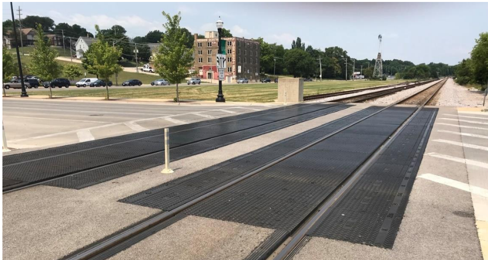
Gambar 2 Contoh Perlintasan Dengan Bahan Karet Penuh ( Full Depth Rubber ) Sumber: Kentucky Transportation Center, 2015
