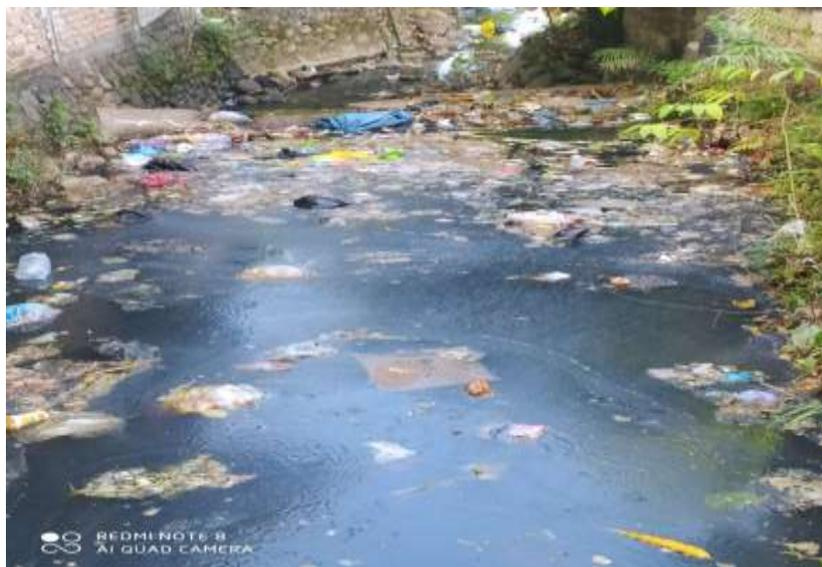
**Gambar 3. Penumpukan sampah di saluran drainase (parit)**
