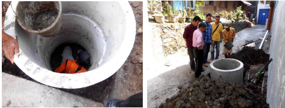
Gambar 4 Pembuatan Sumber Resapan
