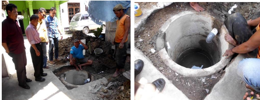
Gambar 5 Uji Coba Sumur Resapan
