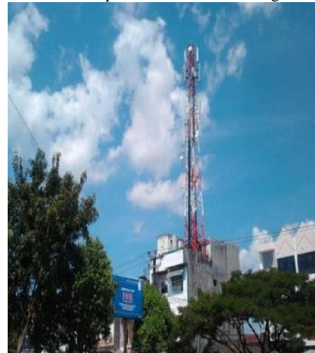
Gambar 1. Menara Bersama Telekomunikasi yang dibangun diatas rumah penduduk. (gojavaraya.com)
