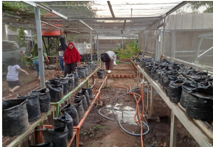
Gambar 2. Proses pembuatan instalasi sprinkler
