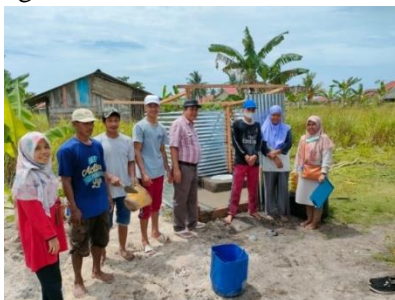
Gambar 3. Monitoring dan Evaluasi Pembangunan Sarana Sanitasi
