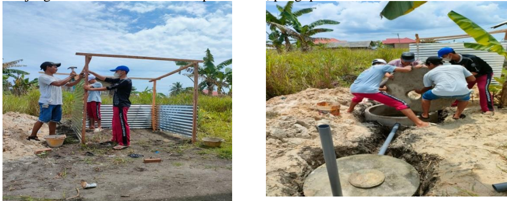
Gambar 2. Proses Pembangunan Sarana Sanitasi
