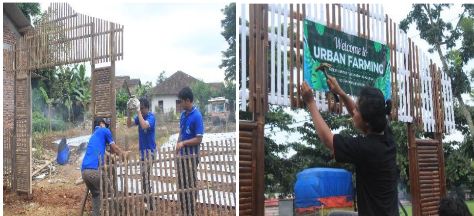
Gambar 5. Pemasangan Gapura Lahan Urban Farming
