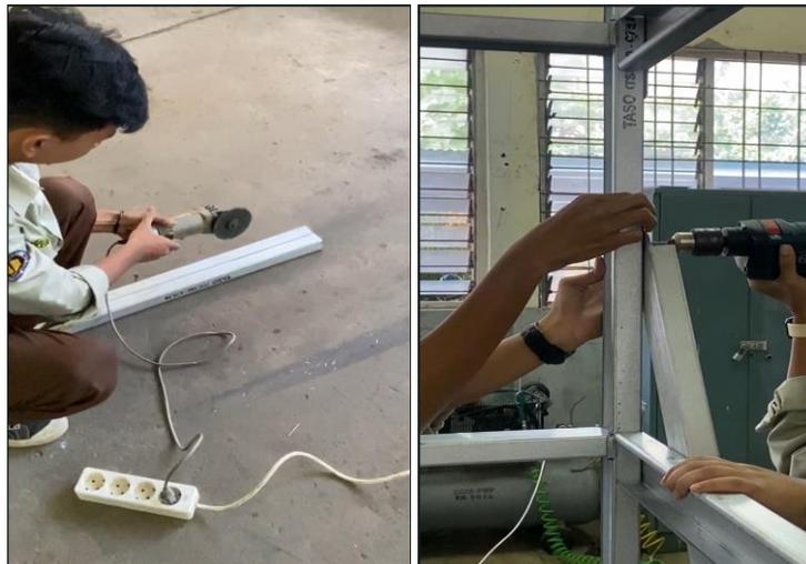
Gambar 2. Pemotongan Baja Ringan dan Penyambungan Baja Ringan
