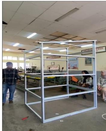
Gambar 3. Proses Perakitan Baja Ringan menjadi Struktur MCK
