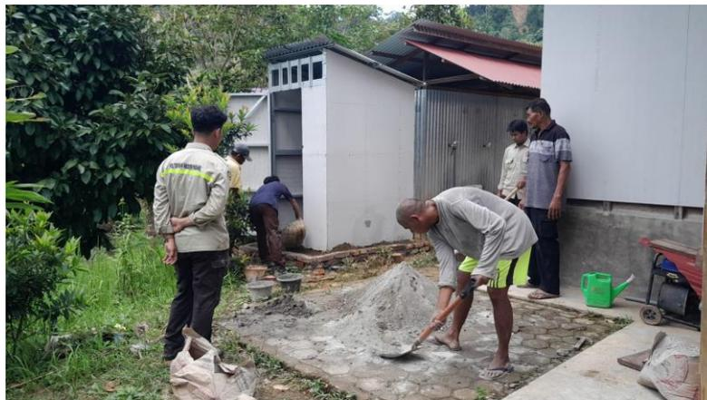
Gambar 4. Proses Peletakan Bangunan MCK di atas pondasi
