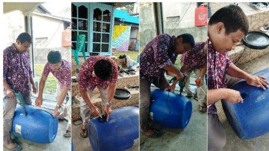
Gambar 3. Proses perakitan alat Instalasi Pengolahan Limbah (Ipal)
