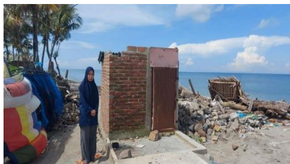
Gambar 1 Kondisi Jamban Penduduk Setelah Terjadi Air Pasang
