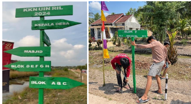
Gambar 2. Pemasangan infrastruktur Lokakarya petunjuk arah
