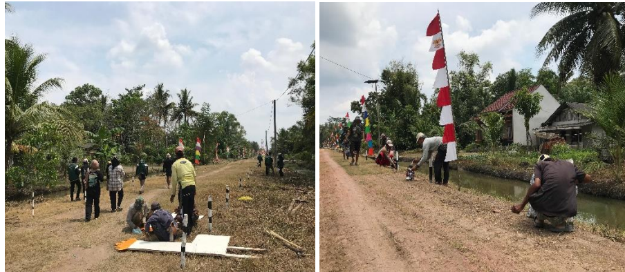
Gambar 1. Kegiatan gotong royong serta pemasangan patok jalan perblok
