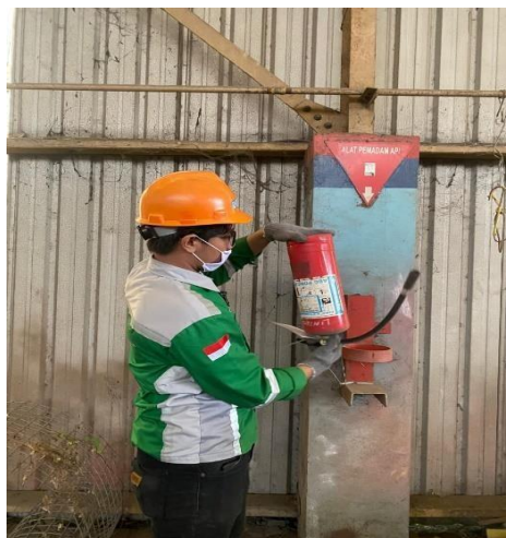
Gambar 2. Pemeriksaan Kondisi APAR
