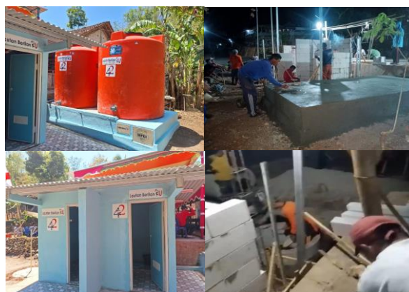
Gambar 2. Pemasangan Instalasi Sanitasi dan Air Bersih
