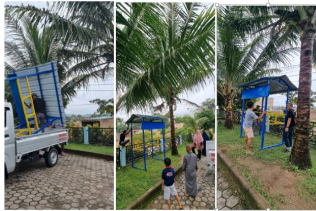
Gambar 4. Proses instalasi pos pengelolaan sampah
