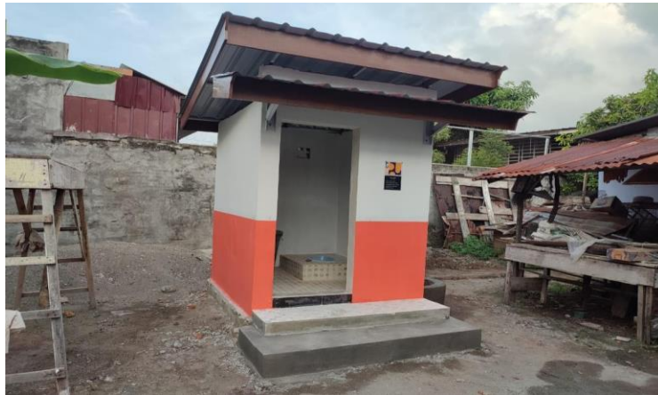
Gambar 1. Toilet yang telah dibangun warga di desa Gampong Baro
