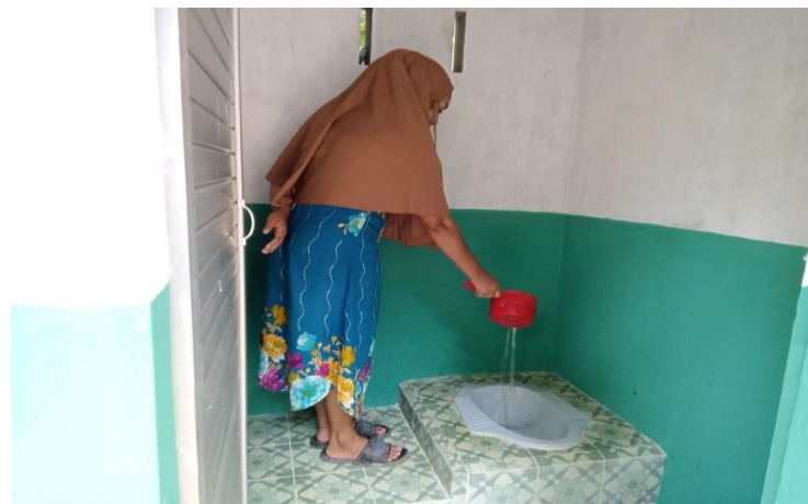
Gambar 2. Warga masyarakat Desa Gampong Baro membersihkan sarana sanitasi atau toilet secara rutin
