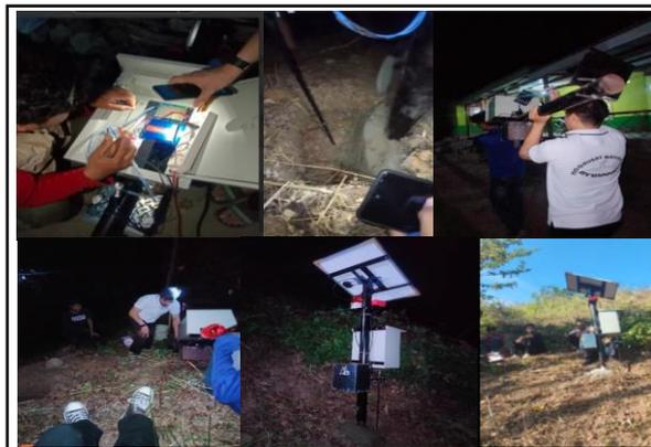
Gambar 5. Pemasangan alat deteksi tanah longsor di bukit belakang rumah Warga Desa Totopo
