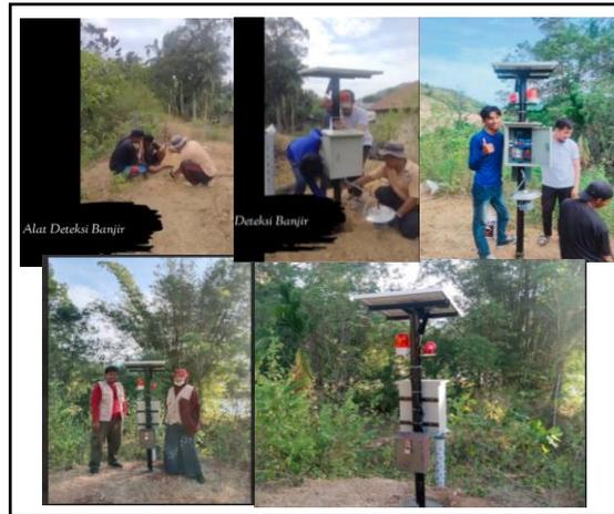
Gambar 4. Pemasangan alat deteksi banjir di tepi Sungai Paguyaman, Desa Totopo.
