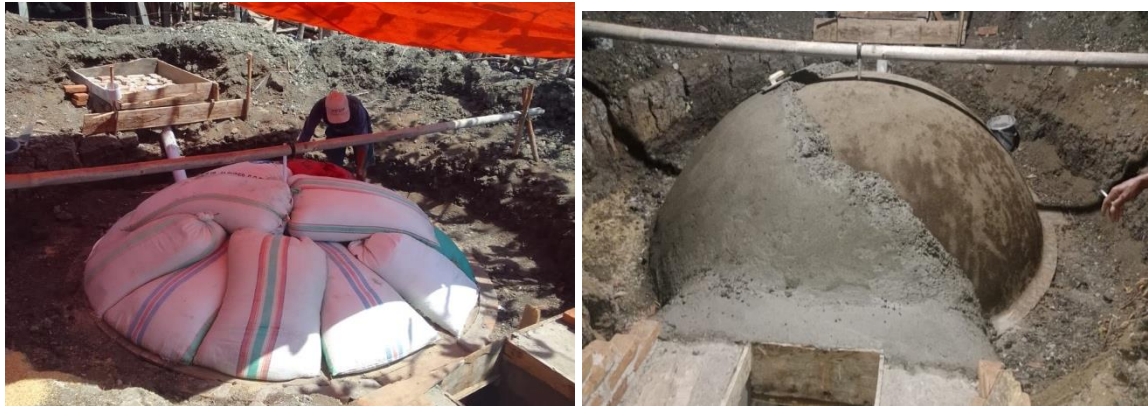
Gambar 2. Proses Pembangunan Instalasi Digester Biogas
