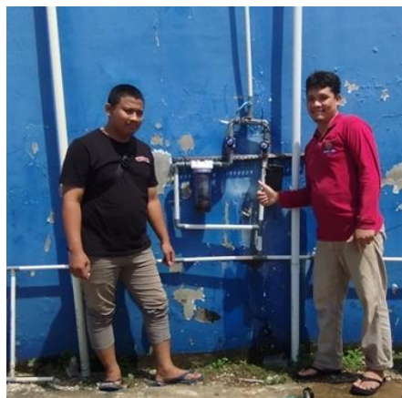
Gambar 5. Pemasangan Dan Intalasi Alat
