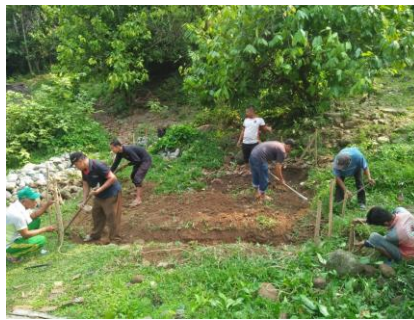
Gambar 3. Masyarakat bergotong royong membangun fasilitas toilet dan sarana ibadah
