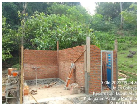
Gambar 4. Progress Pembangunan Fasilitas Toilet dan Sarana Ibadah
