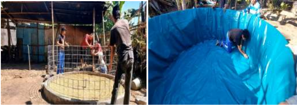
Gambar 4. Pemasangan kerangka besi berdiameter 3 meter lalu dipasang terpal kolam ikan yang sebelumnya ada terpal pelapis antara kerangka besi dengan terpal kolam ikan.
