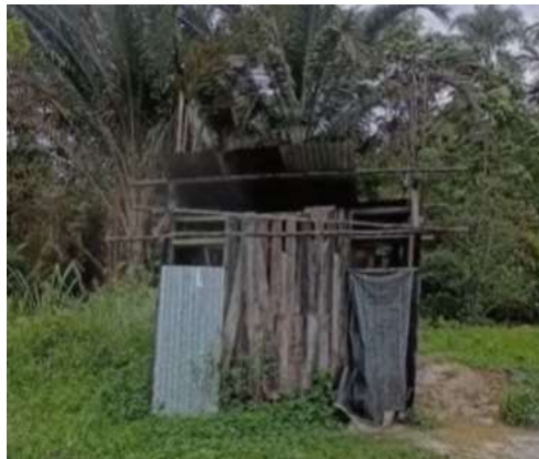
Gambar 3. MCK/Toilet Sebelumnya di Objek Wisata Kali Biru Kampung Berab Kabupaten Jayapura
