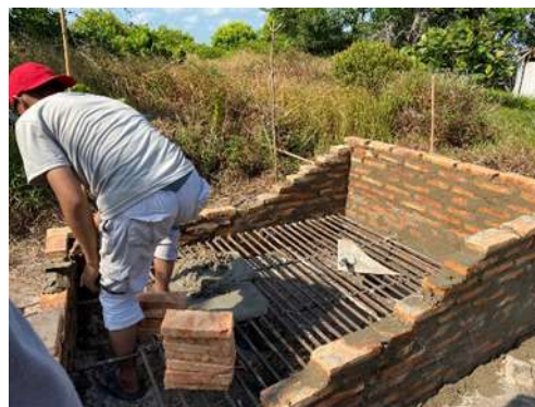
Gambar 9. Pemasangan dinding bak pembuangan sampah
