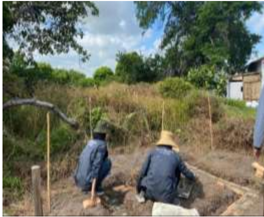
Gambar 7. Pemasangan rollag bata.
