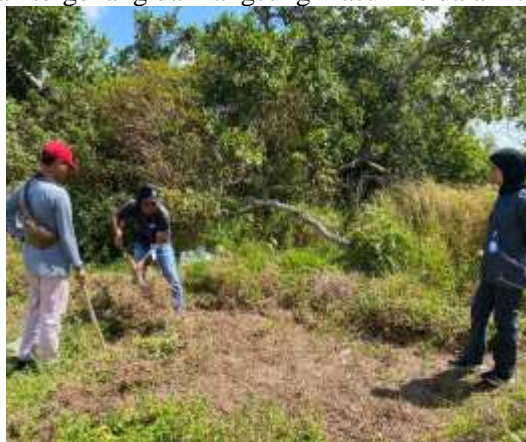
Gambar 6. Penggalian tanah pondasi
