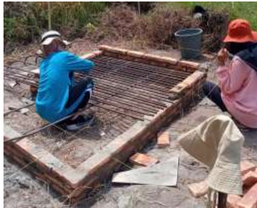
Gambar 8. Pemasangan hambaran besi sebagai penyaring
