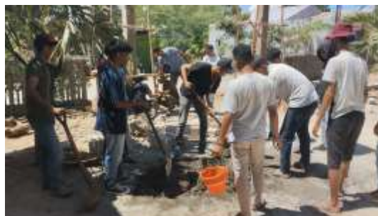
Gambar 4. Pembangunan Gapura Desa Penfui Timur Bersama Para Pekerja Bangunan dan Mahasiswa KKNT Fakultas Teknik, Universitas Katolik Widya Mandira
