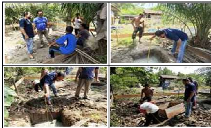
Gambar 3. Pengarahan Pekerjaan, Pengukuran Lantai Kerja Pondasi dan Cetakan Pondasi Tapak
