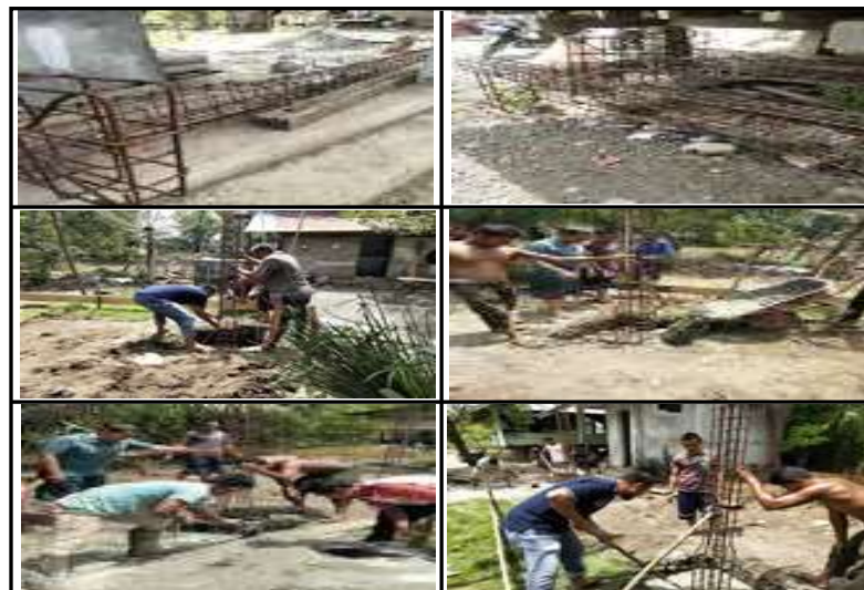
Gambar 4. Tulangan Pembesian Pondasi Tapak, Peletakan Pembesian, Pengecoran dan Pematatan Adukan Semen Dengan Stik Kayu
