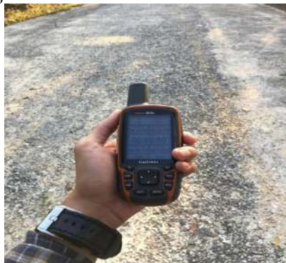
Gambar 4. Mengambil Titik kerusakan Jalan
