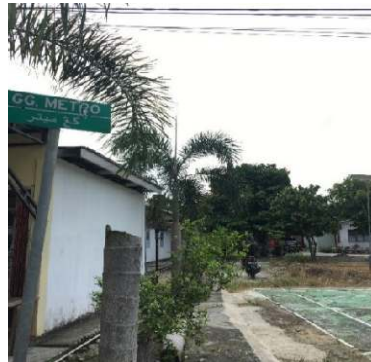
Gambar 7. Kerusakan Gg. Metro
