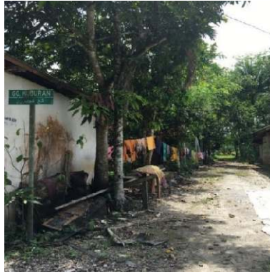
Gambar 8. Kerusakan Gg. Kuburan
