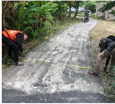
Gambar 2. Pengukuran Dimensi Jalan
